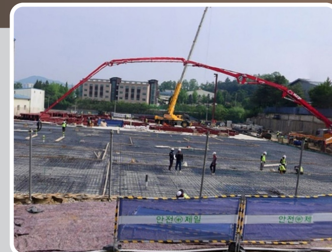
대상(주) - 황성 종가집 공장 기초
